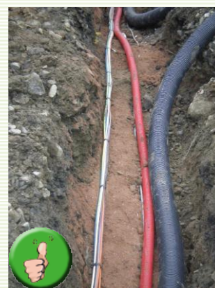
Obr. 4 Svazování mikrotrubiček
