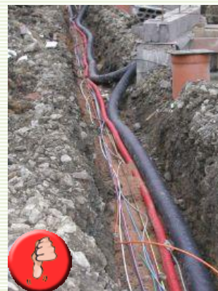
Obr. 3 Ondulace MT ve výkopu
