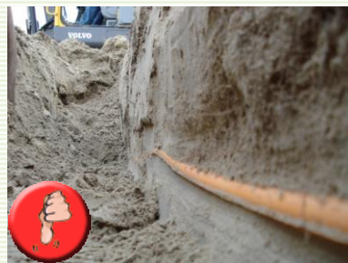
Obr. 1 Zvlnění MT – nezhutněné lože
